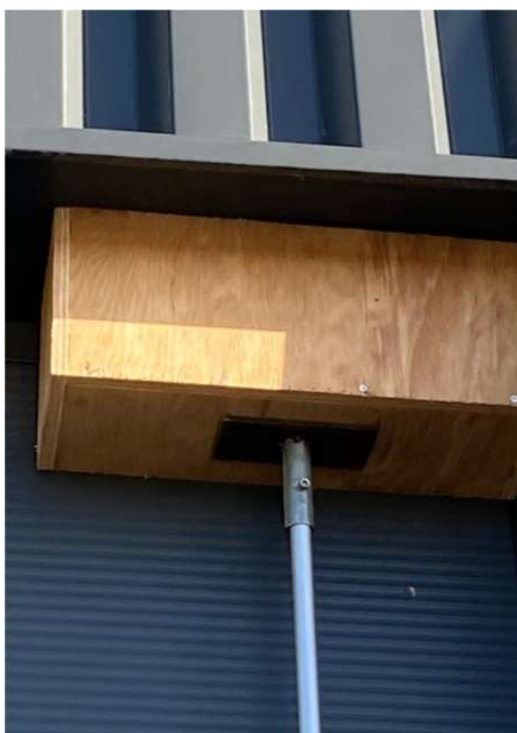
Caisson à 3 faces permettant de travailler autour des nids situés dans les angles
